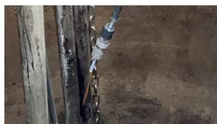
Aus der ehemaligen Chemiedosierstation (Bild oben rechts) wird über eine kleine Spritzpumpe (Bild unten links) kontinuierlich Triaterra-aktiv in den Schacht (Bild oben links) geträpfelt.
