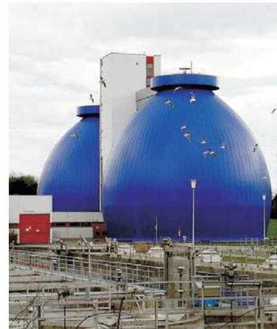
Abwasserentsorgung über Kläranlagen belastet Flüsse, verschwendet Trinkwasser und raubt den Böden ihre Fruchtbarkeit. Die Kegel-Bauwerke dieser Kläranlage sind sog. „Faultürme“. In ihnen wird Klärschlamm so aufbereitet, dass er irgendwann in Müllverbrennungsanlagen verbrannt werden kann. Was für ein Aufwand! Wie viel einfacher, sinnvoller und umweltfreundlicher wäre da die Verarbeitung von menschlichem Dung zu fruchtbarer Terra Preta?
